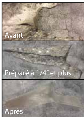
Surfaçage dans une usine alimentaire avec KIRC9000. 15min durcissage. 1h passeront les chariots.
